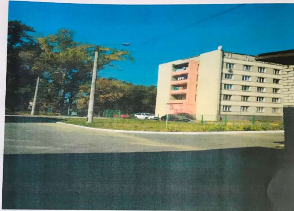
Подъезд продуктовой автомашины к кухонному блоку
